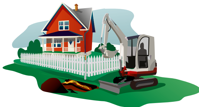
Bild 33 - Vid arbete bör man kontakta elnätsföretaget i god tid innan arbetet påbörjas för kostnadsfri utsättning av kablar.
